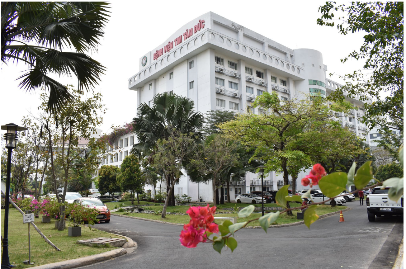
Bệnh viện Tim Tâm Đức, khu vực mới xây dựng 2012
