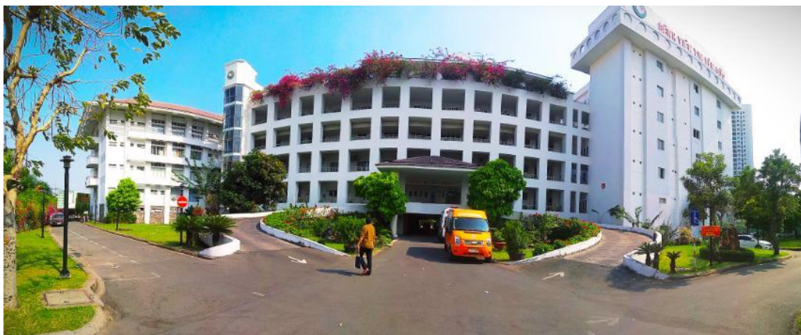
Đường vào cấp cứu TÂM ĐỨC
